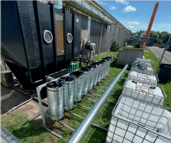
Biofilter zur Abluftreinigung/Methanoxidation
